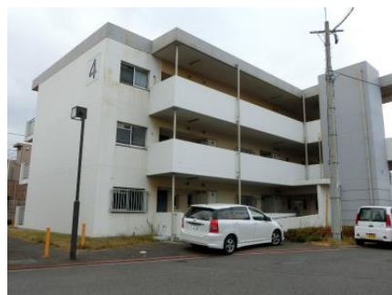
住環境整備事業で建てられた コミュニティ住宅
