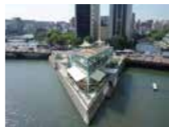
SHIP'S GARDEN 松岡恭子・井手健一郎・高島宗一郎・ 倉富純男・松本優三 株 スピングラス・アーキテクト/株 リズムデザイン /福岡市/西日本鉄道(株)/株 松本組 福岡県福岡市
