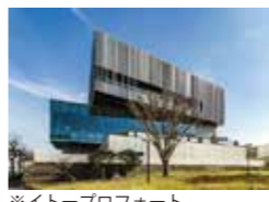
熊本県民テレビ新社屋プロジェクト 青柳武宣・松井健太郎・大迫公生・ 太田俊也・酒寄弘和・岩間寛彦・ 吉瀬維昭・宮西紀彰・野嶋敏 株 三菱地所設計
