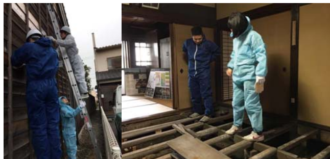
岩松家修繕ワークショップ [外壁塗装・床組修繕]
