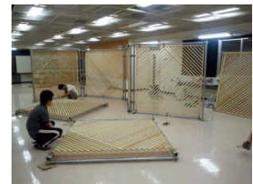
写真2 壁面の仮施工
