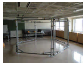
写真1 躯体の仮施工
