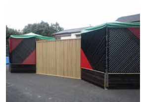
写真4 建築物の外観
