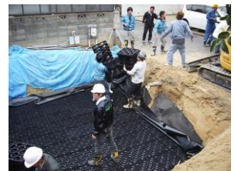
ユニット式タンクを敷き詰める
