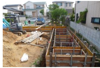
基礎を兼ねたタンク施工中
