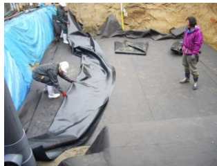
駐車場地下の防災用タンク施工
