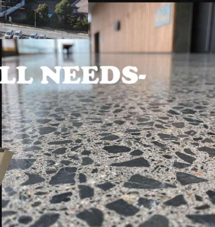
クリスタルハード~コンクリート化粧仕上げ工法
