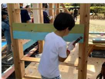
外壁板を張る
