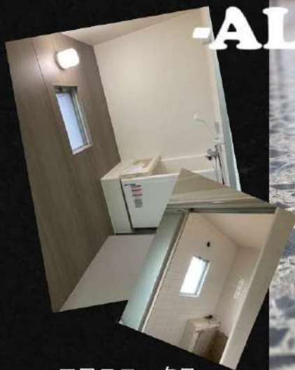
エフユニックス 浴室改修工法
